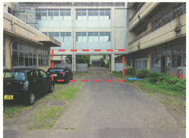
段差解消（1F渡り廊下）
