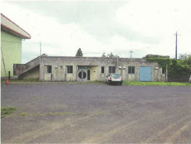
プール改修 管理棟
