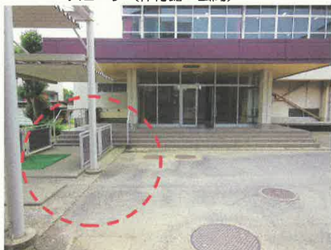
スロープ（体育館 玄関）
