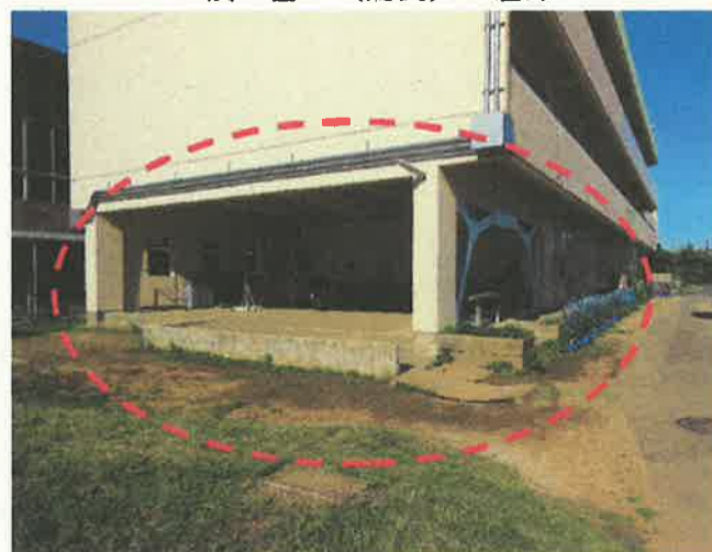
校 舎 （南側） 倉庫
