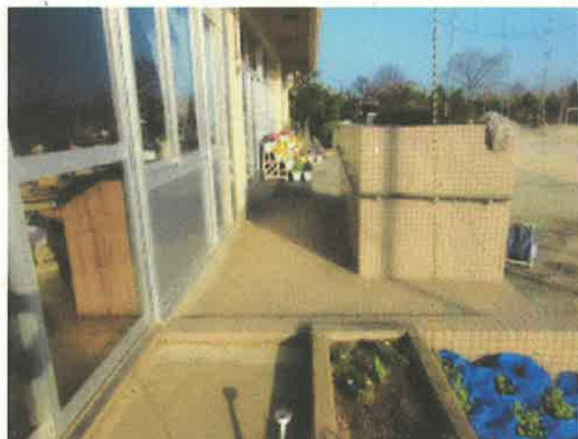
⑫ スロープ（南側校舎）
