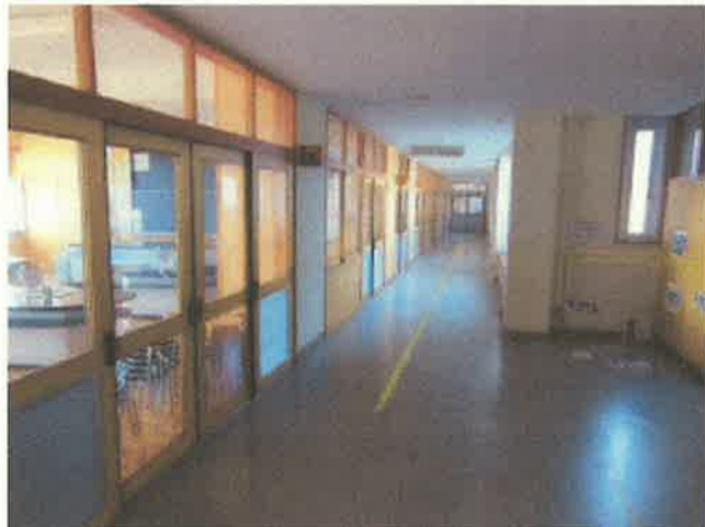
⑦ 廊 下（南側校舎）
