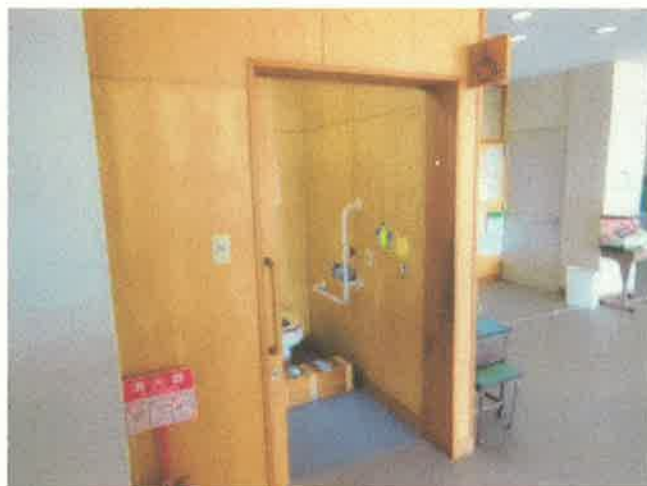
⑪ 多目的トイレ（南側校舎）
