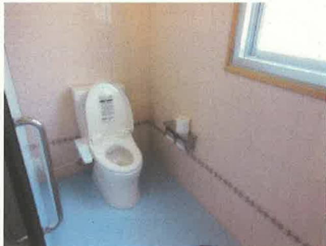
⑨ トイレ（南側校舎）
