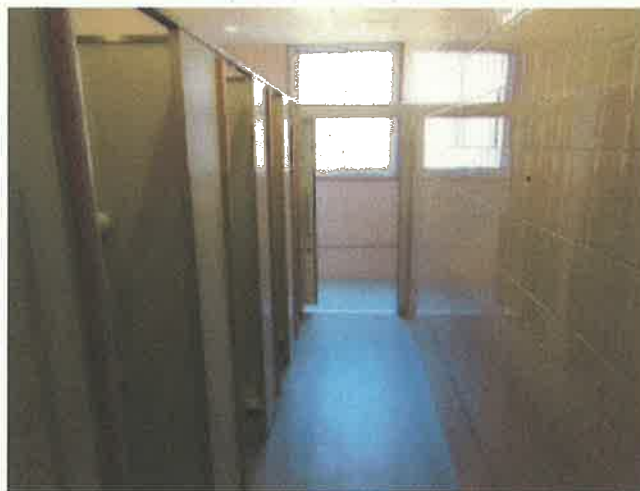
⑨ トイレ（南側校舎）
