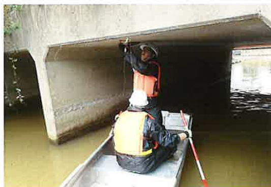
写真-3.1 点検の状況
