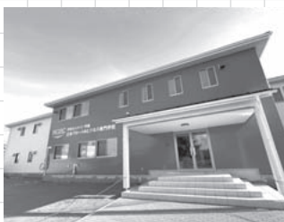
グローバルビジネス専門学校2号館
