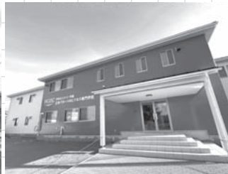
グローバルビジネス専門学校2号館
