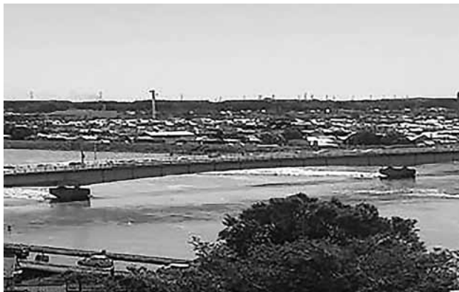
令和元年 東日本台風における栄橋の様子
