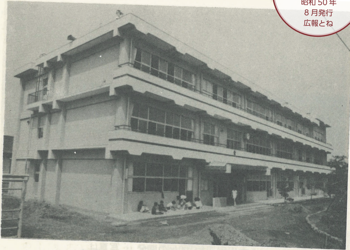
▲鉄筋コンクリート3階建ての文間小学校。 総工費1億5,300万円。7月17日竣工式を 挙げる。
