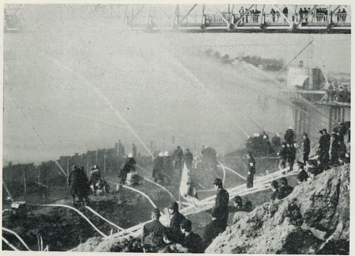
写真=返りしぶきを身に浴びながら、各分団ごとに行なわれた放水試験。 右上に見えるのが栄橋の建設現場です。
