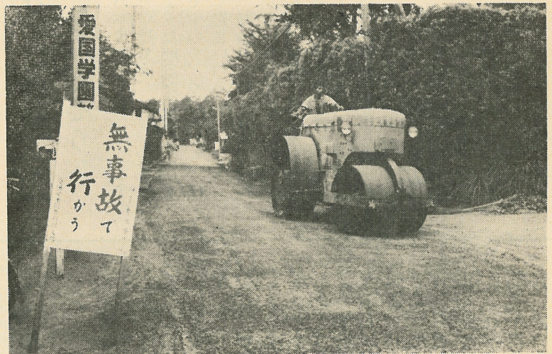
写真は、ローラーで最後の仕上げ。……こうして舗装は逐次進められておりますが、道路がよくなるとスピードの出し過ぎによる事故なども起こりがちです。お互いに気をつけましょう。
