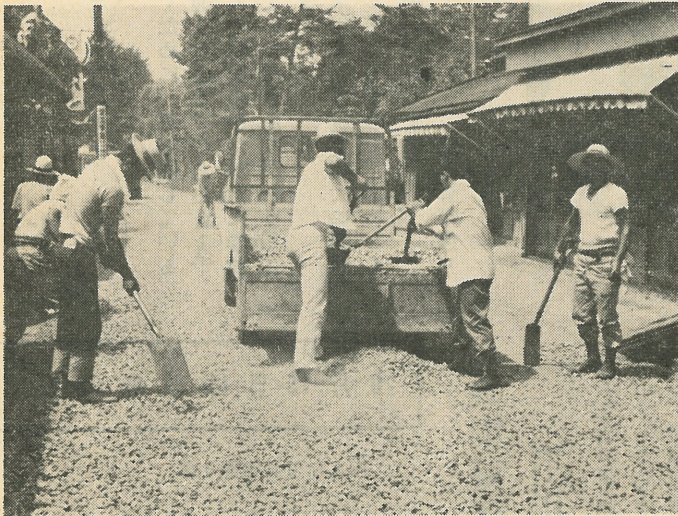
写真は、碎石を平らに敷きつめる作業。炎天下の8月24日布川の馬場で写す。
