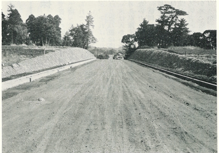
写真は幅員9.5mの栄橋取り付け道路です。
