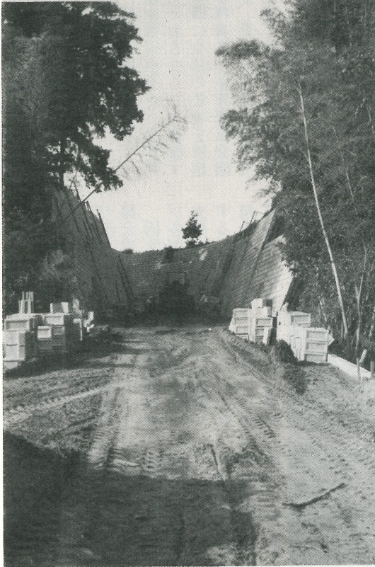
▲公会堂横の坂の工事の進捗状況を10月3日に撮影したものです。
