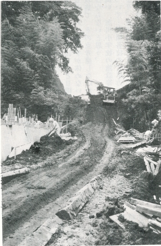
写真は公会堂横から台地へ通じる坂の工事です。難工事ですが、9月中頃までに完成する予定です。6月30日写す。
