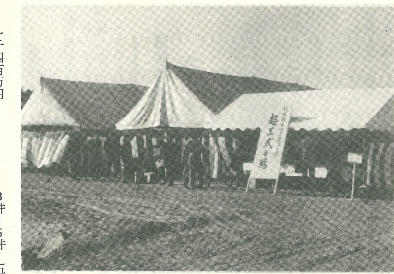
▲1日24日 利根町上水道建設工事起工式が行われました。詳細については、順次お知らせいたします。
