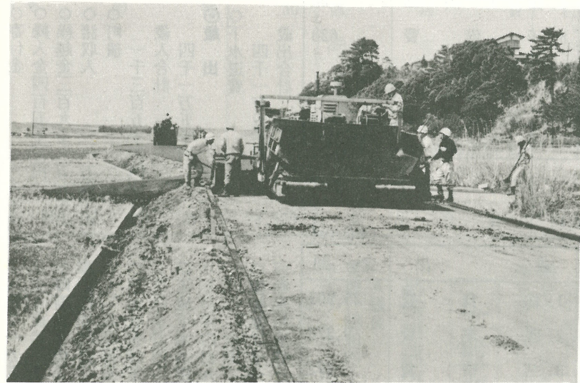
▲この写真は、産業道路の舗装工事で、3月半ばに撮影したのですが、現在では、羽根野から横須賀までの2,557mが立派に完成しております。
