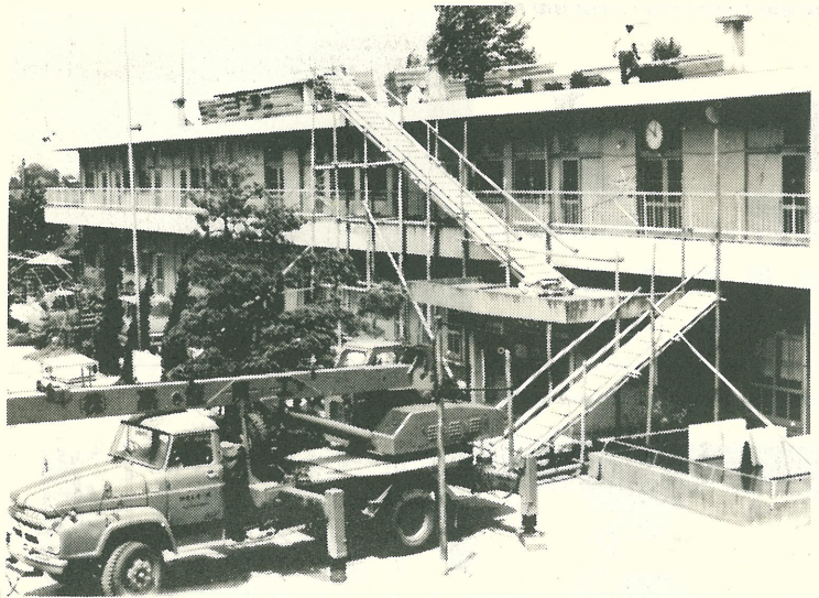
▲夏休みを利用して東文間小学校の屋根の修理が行われました。工費 550 万円、常総開発工業 K K 施工。
