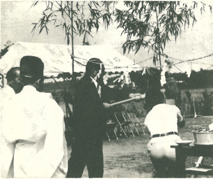
▲9月6日、東文間小学校屋内運動場の起工式が行われました。完成は来年2月28日の予定。
