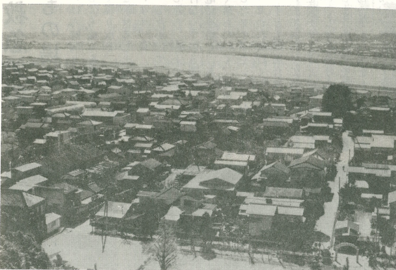
▲写真は、水道高架タンクの頂上から撮影した布川の町並で、白く見えるのが利根川です。
