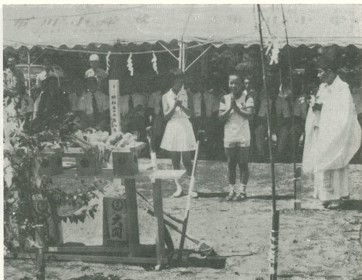
▲ 8月22日に行なわれた布川小学校の地鎮祭。この日生徒代表も玉串を捧げて工事の無事を祈りました。
