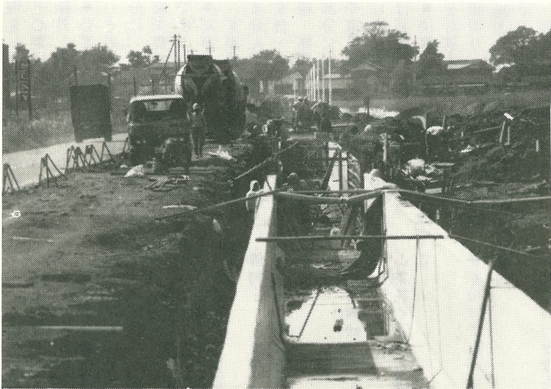
▲下水道の建設は目下の急務。 10月29日利根ニュータウンで写す。
