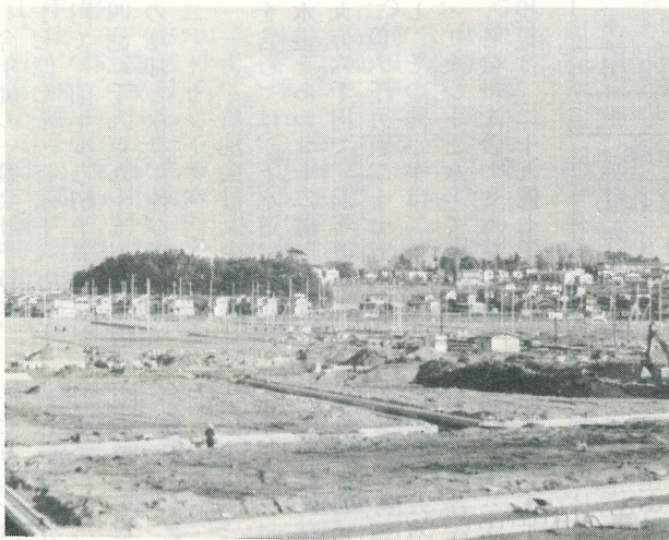
▲ 住みよい町づくりをめざして、着々と進む宅地造成事業。 (利根川堤防よりフレッシュタウンを望む)
