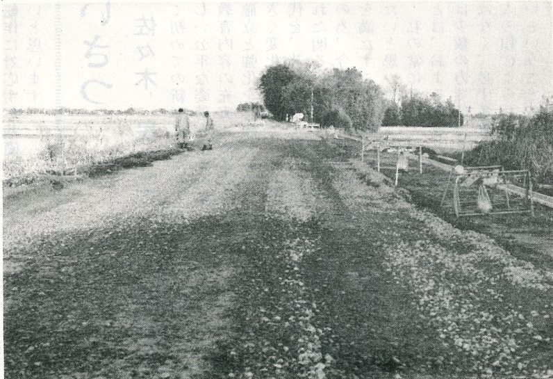
▲ 県道取手小巻線，自転車・歩行者道設置のための 拡幅工事。(加納新田にて撮影)
