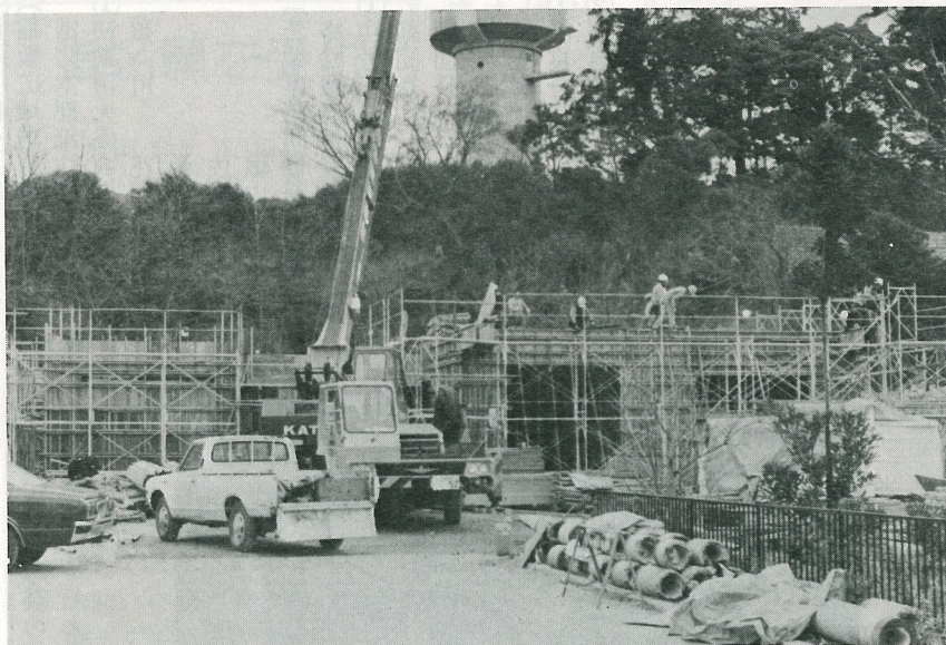
▲写真は、工事が進められている「利根町保健センター」新築工事現場。3月に完成予定です。
