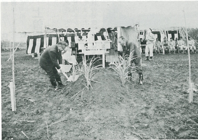
▲ 5月1日、県立高校敷地造成工事の地鎮祭が 執り行われました。
