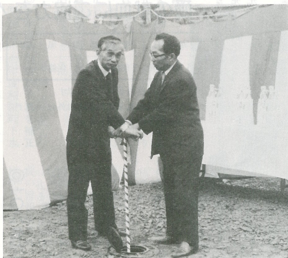
▲ 4月1日の通水式で、開栓する鈴木町長と堀越水道運営協議会々長。
