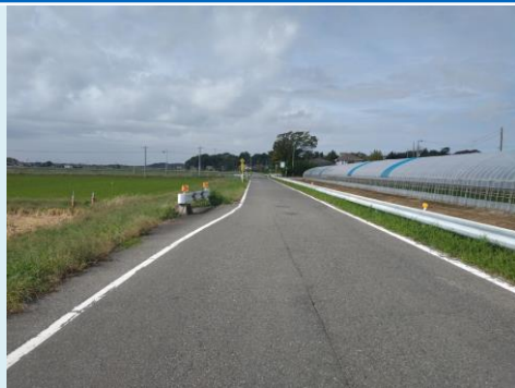
改良工事前（町道101号線）
