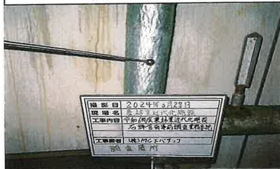
34 栽培棟 機械室 蒸気配管 調査中
