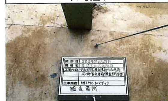
40 覆土調整室・機械格納庫 床 調査中
