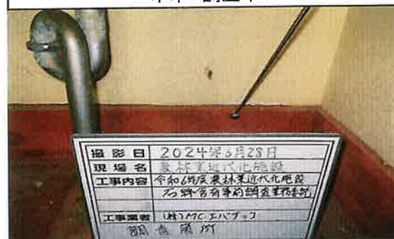
12 栽培棟 便所 巾木 調査中
