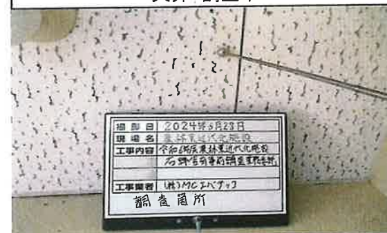
15 栽培棟 便所 天井 調査中
