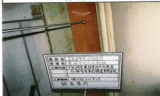
35 栽培棟 機械室 柱 調査中
