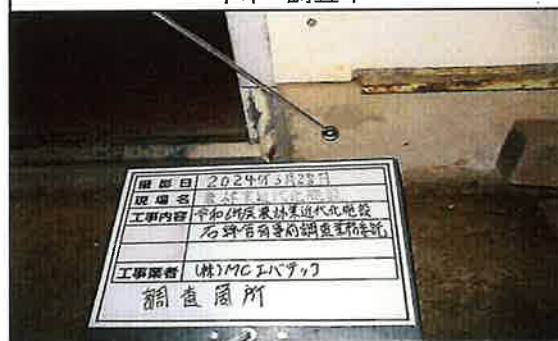
31 栽培棟 機械室 巾木 調査中
