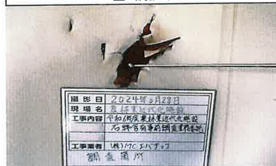
36 栽培棟 予冷库 壁 調査中
