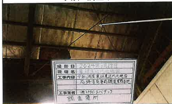
10 栽培棟 出荷調整室 天井 調査中
