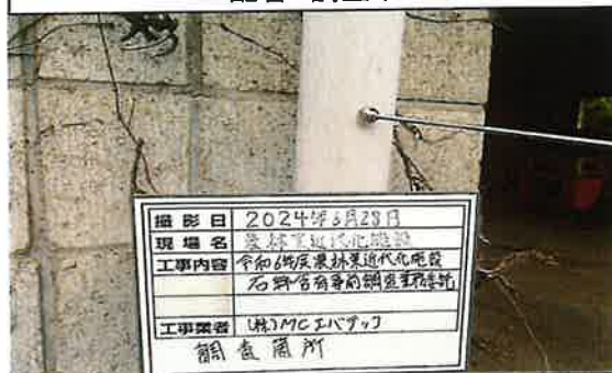
42 覆土調整室・機械格納庫 配管 調査中
