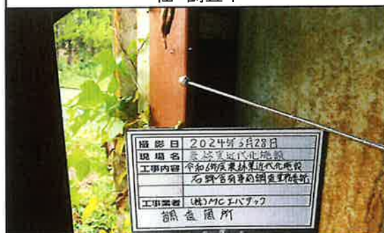
29 栽培棟 通路 柱 調査中
