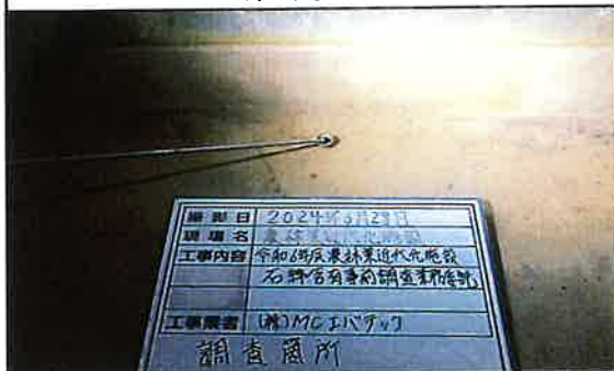
17 栽培棟 栽培室 床 調査中
