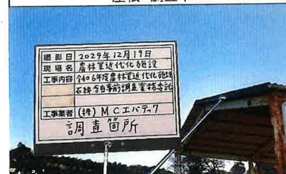
47 屋外堆積場 屋根 調査中
