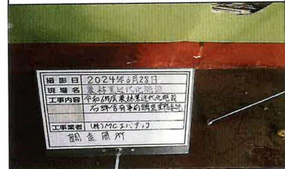
6 栽培棟 出荷調整室 床 調査中
