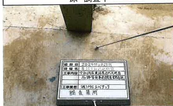
43 屋外堆積場 床 調査中
