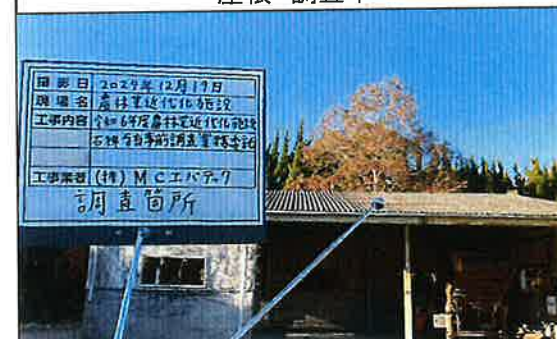
46 覆土調整室・機械格納庫 屋根 調査中
