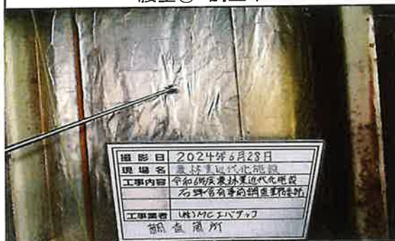
9 栽培棟 出荷調整室 腰壁② 調査中
