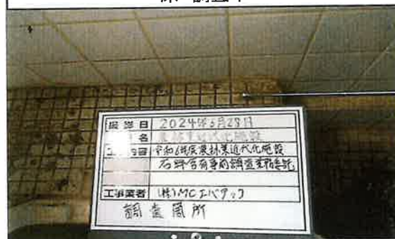
11 栽培棟 便所 床 調査中
