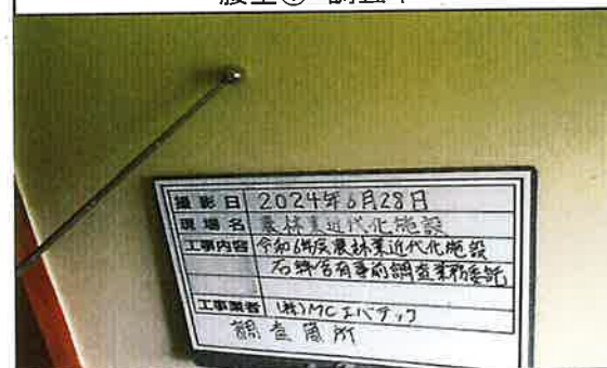
13 栽培棟 便所 腰壁① 調査中
