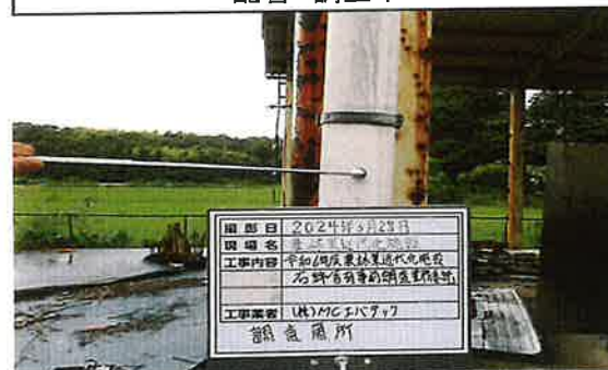
44 屋外堆積場 配管 調査中
