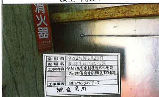
27 栽培棟 通路 腰壁 調査中
