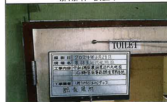
16 栽培棟 便所 扉、扉枠 調査中
