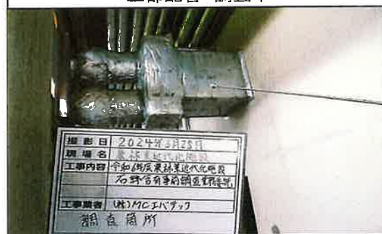
28 栽培棟 通路 上部配管 調査中
