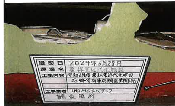
7 栽培棟 出荷調整室 巾木 調査中
