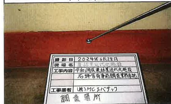
23 栽培棟 通路 巾木 調査中
