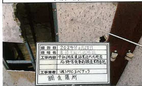
5 栽培棟 事務所、休憩室、更衣室 天井 調査中
