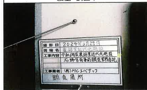
32 栽培棟 機械室 腰壁 調査中
