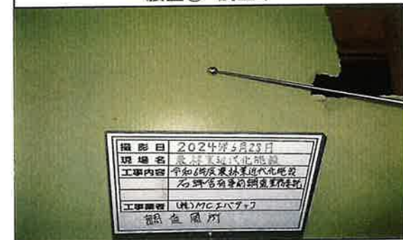
8 栽培棟 出荷調整室 腰壁① 調査中
