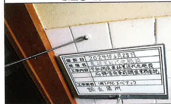
14 栽培棟 便所 腰壁② 調査中
