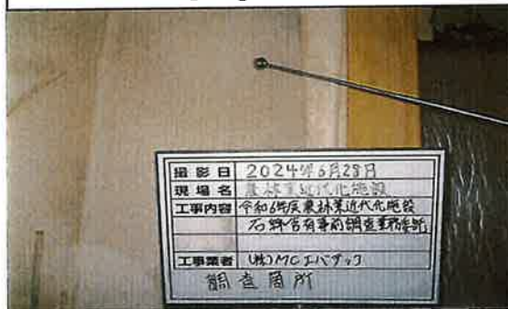
3 栽培棟 事務所、休憩室、更衣室 腰壁① 調査中
