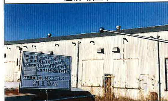
45 栽培棟 屋根 調査中
