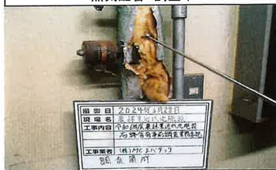
26 栽培棟 通路 蒸気配管 調査中
