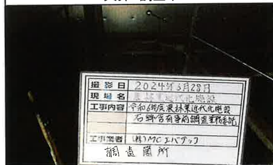
21 栽培棟 栽培室 天井 調査中
