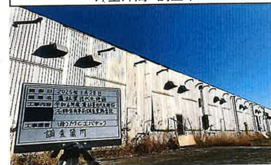
48 栽培棟 外壁外周 調査中
