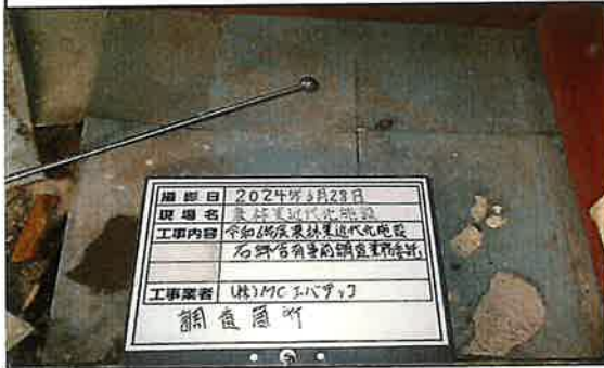
1 栽培棟 事務所、休憩室、更衣室 床 調査中
