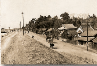
堤防補強前の栄橋付近 昭和31年4月 (1956年)
