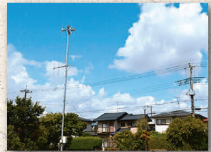
利根町地域防災無線運用開始 平成7年 (1995年)
