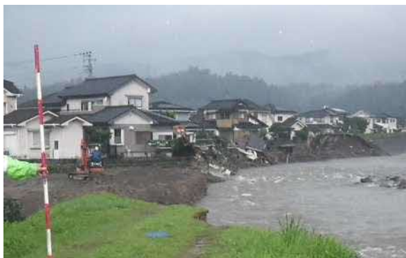
河岸侵食による家屋の倒壊(花月川)
