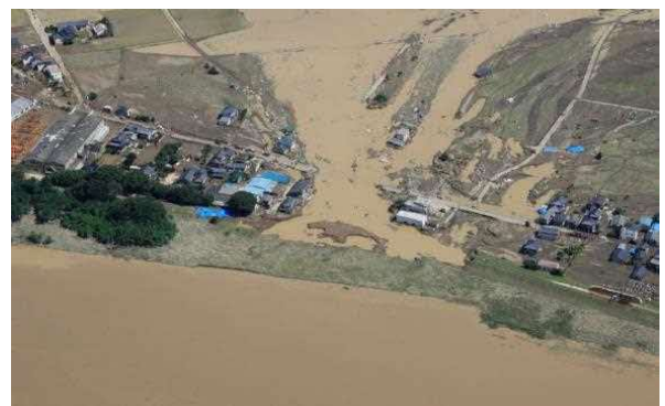
堤防決壊による家屋の流失(鬼怒川)
