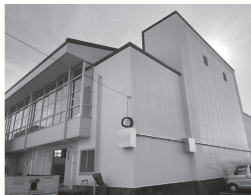
体育館の改修工事と空調設備を設置
