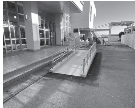
昇降口にスロープを設置
