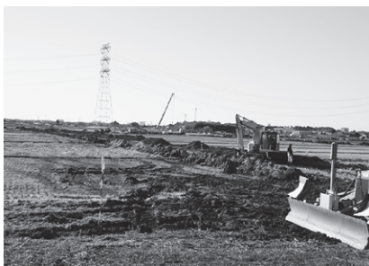
横須賀地内で行われている 整地工事
