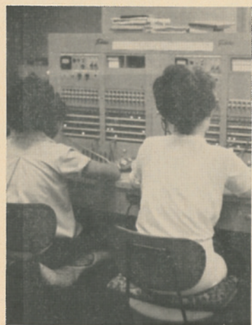
有線放送交換室と交換手 (写真は昭和41年10月10日発行広報とねより)
