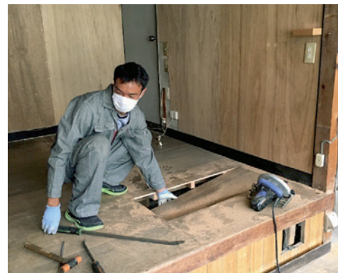
リノベーション中の店内の様子。アイデアを出しながら、一つ一つ丁寧に作業が進められた
