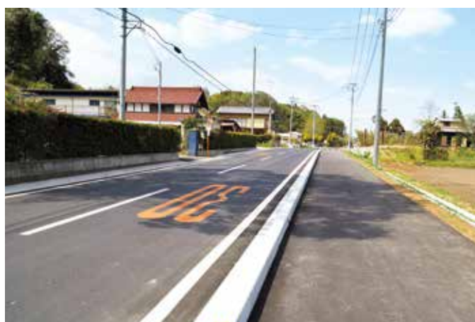
町道112号線(立木地内)
