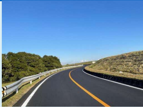
修繕工事後 (町道109号線)
