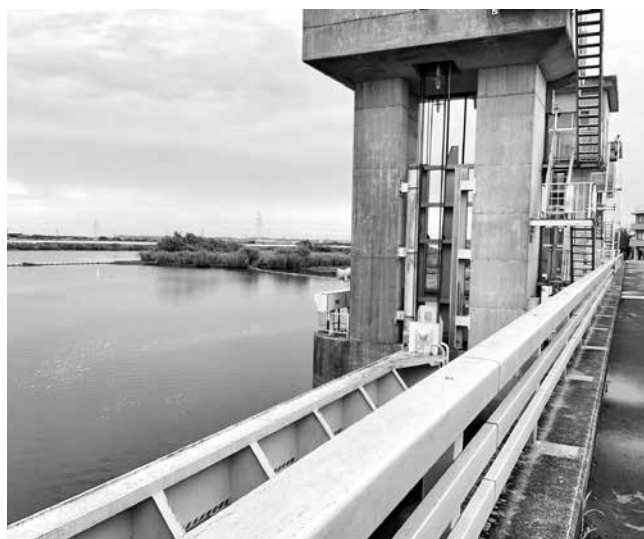
▲新利根川河口水門
