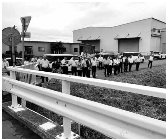
▲新河橋（稲敷市内）
