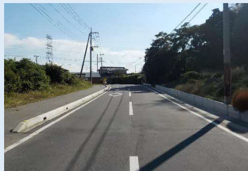
改良工事後（町道112号線）
