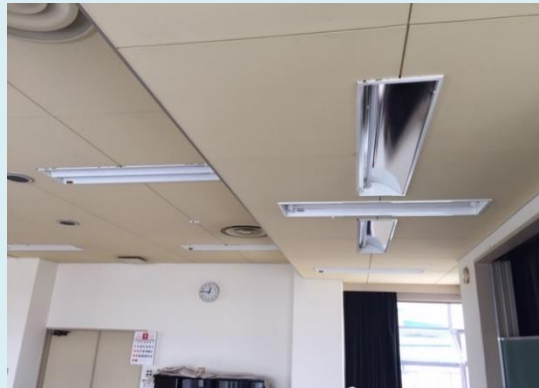
LED交換工事
