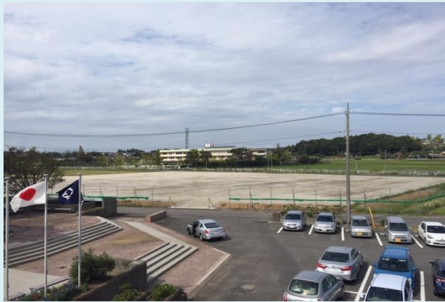
駐車場整備工事
