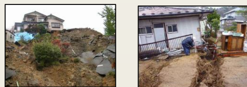
滑動崩落の事例
