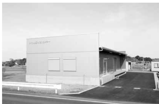
▲押付地区水防センター
