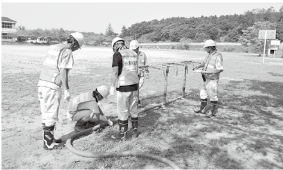
▷手際良く臨時の給水所を設置
